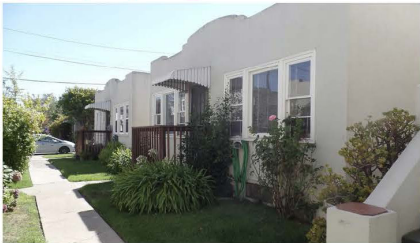
Image A: Conjunto De Viviendas
