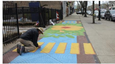
Fix roads and sidewalks to make them drain better to keep them in good condition Arreglar calles y andenes para que desagüen mejor y se mantengan en mejores condiciones
