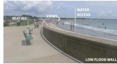
Create elevated flood barriers that can enhance public space Crear barreras elevadas anti inundación que conlleven mejoría del espacio público
