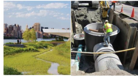
Water retention above or below ground Retener agua encima o debajo del nivel del suelo
