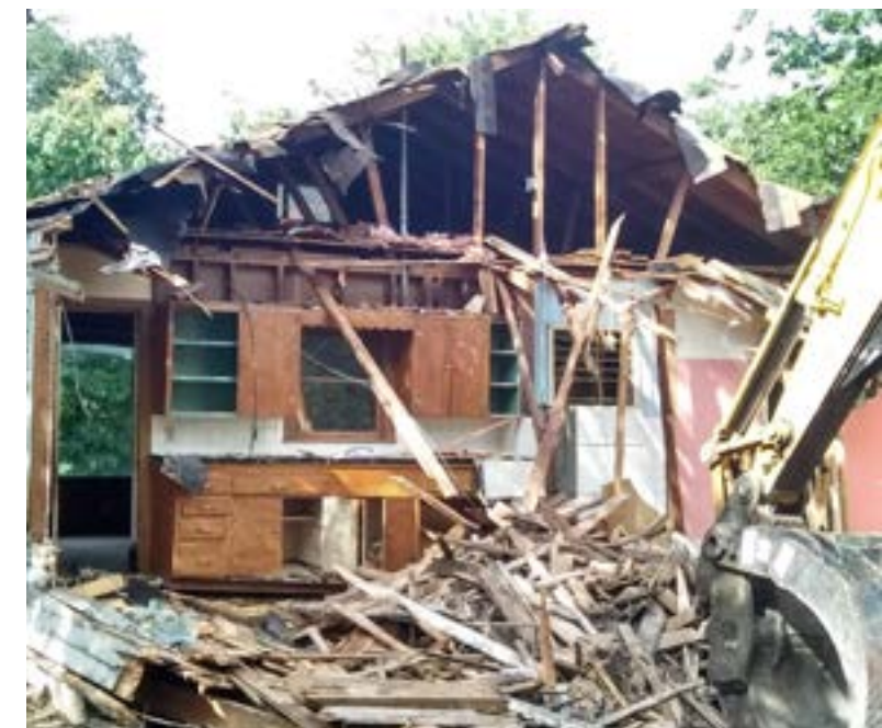
▲ Vivienda más antigua durante demolición
