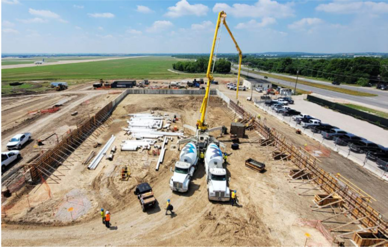
Concrete pour for dike walls
