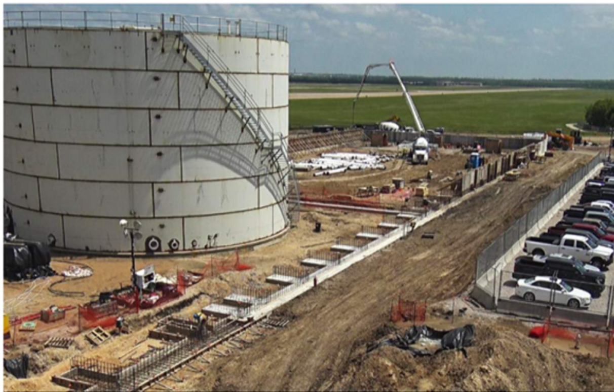
Concrete pour of dike walls
